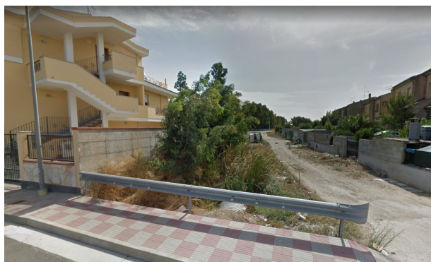
Figura 2: Canale a cielo aperto “Zona Bruscu Argius” in prossimità di via Toscanini (foto repertorio 2012 e 2022 fenomeni vegetazioni che intasano la sezione idraulica)
